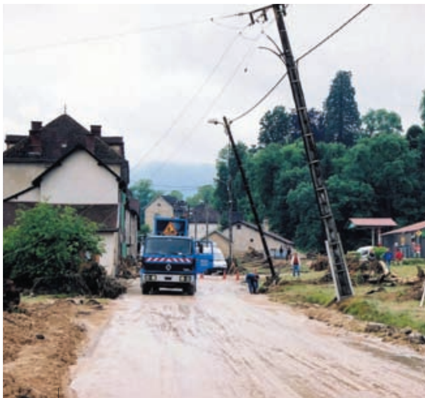
Crue de torrent - Sainte Geoire en Valdaine rétablissement du réseau électrique - juin 2002
